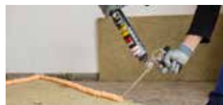
Isolation des murs intérieurs et mitoyens
