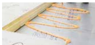
Isolation de toits plats (min. 5 cordons de colle par m)
