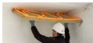
Isolation au plafond
