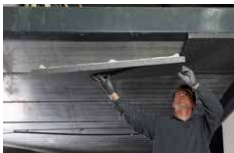
3. Bevestig de plaat na 5 min.
