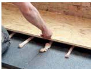
5. Plaats de ondervloer haaks op de isolatieplaten.
