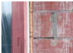
1. Profielen en aansluitingen moeten geplaatst zijn.
