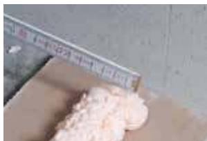
lijmstreng Ø 3 à 4 cm oneffenheid uitvlakken (max. 1 cm)
