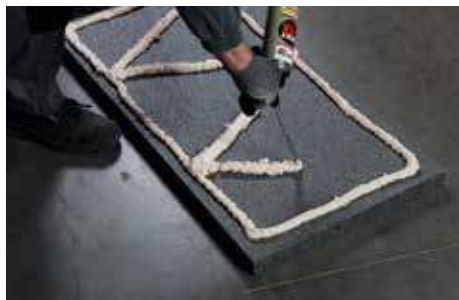
1. Breng de lijm aan in zigzag vorm.
