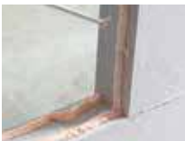
Verlijmen van cellenbeton
