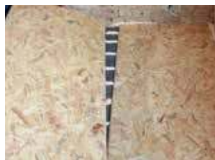
6. Klik de platen in elkaar en druk stevig aan. Loop niet over de platen tot na uitharding van de lijm.
