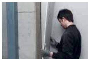
4. Plaat op zijn plaats zetten en aanduwen
