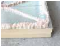
Verlijmen van isolatieplaten
