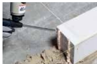
6. Kimblokken mogen verticaal opgevoegd worden
