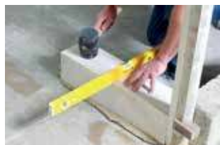
4. Eerste blok waterpas plaatsen
