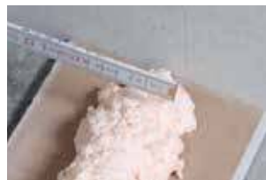
lijmstreng Ø min. 5 cm oneffenheid uitvlakken (max. 2 cm)
