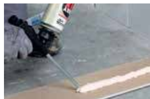
6. Pistool opendraaien en plaat inlijmen
