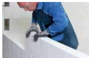
9. Plaats de steen in de lijmlaag
