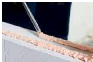
8. Breng 2 evenwijdige lijmslangen aan
