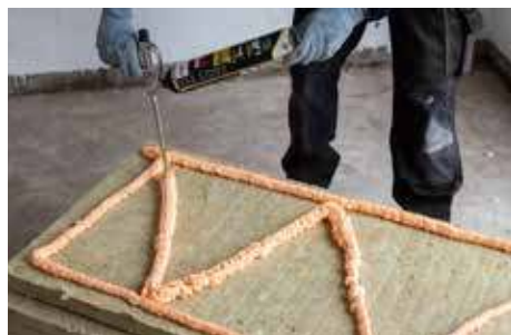
1. Breng de lijm aan in zigzag vorm.
