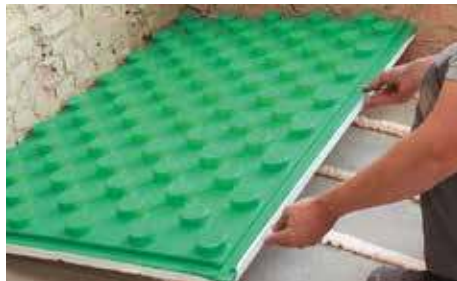
2. Plaat aanbrengen in de lijmlaag.
