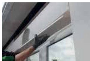
6. Bovenstuk van dagkant plaatsen
