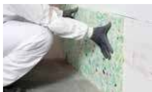
3. Tegen de ondergrond plaatsen en 1 min vasthouden.
