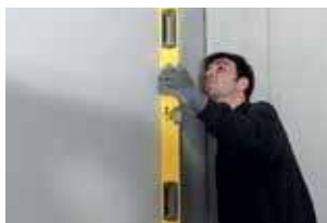
5. Waterpas controleren en bijduwen waar nodig
