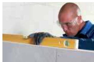
12. Controleer de pasheid na elke laag
