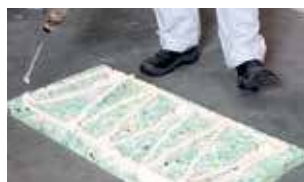
1. Plaat inlijmen met Easy Fix.
