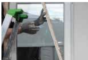
8. Steunbalk plaatsen en zijkant 2
