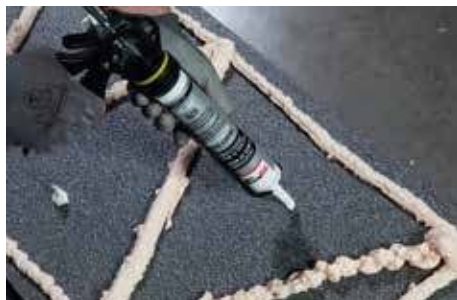
2. Plaats tussenin dotted montagelijm met hoge aanvangshechting.
