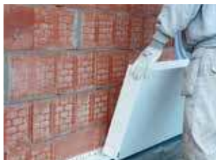
5. Plaat op zijn plaats brengen.
