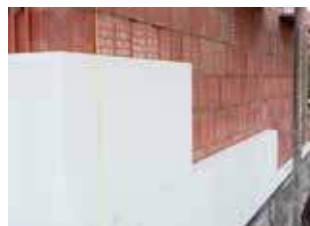
9. Na ca. 1u uitgehard zodat er verder afgewerkt kan worden.
