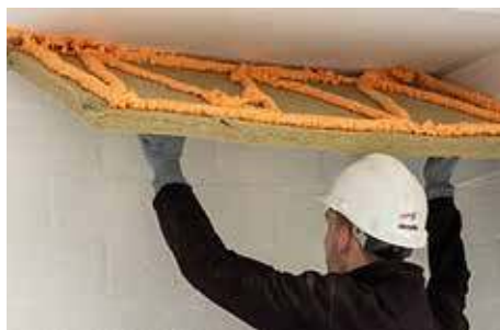
2. Plaat aanbrengen binnen 2 min.
