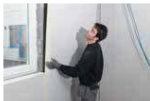
4. Plaat op zijn plaats zetten en aanduwen
