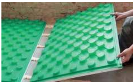
3. Lijmlaag dichtleggen.
