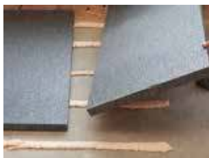
2. Plaats de isolatie loodrecht op de lijmrillen. Druk stevig aan.
