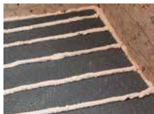
4. Lijm de isolatieplaten in.
