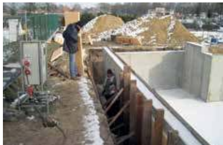
3. Platen op zijn plaats brengen.
