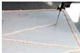
1. Plaat inlijmen met zigzag vormen
