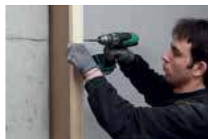
6. Bevestig de balk onder- en bovenaan aan de plaat
