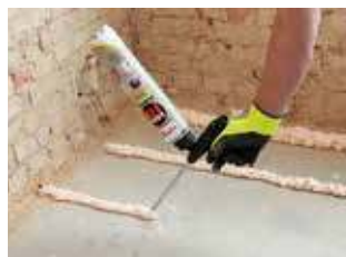
1. Plaats de lijmrillen op de ondergrond.
