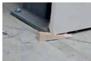
9. Kopse afwerkingsplaat stutten
