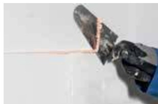
15. Na 1u volledig uitgehard met Easy Fix, na 15 min. met Easy Fix Turbo. Afwerking kan beginnen.
