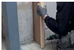
5. Schroef een balk links van de plaat
