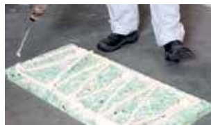
1. Encoller le panneau avec Easy Fix.
