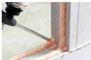
10. Encoller aussi les joints verticaux
