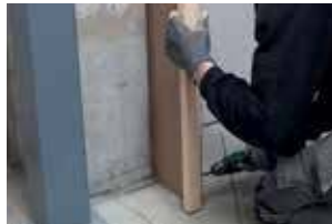
5. Visser une poutre à gauche du panneau
