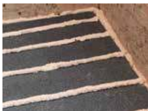
Isolation du plancher des combles
