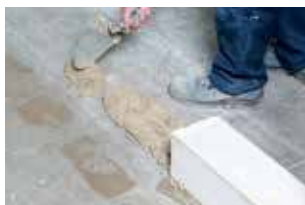
5. Travailler en suivant un cordeau de maçon
