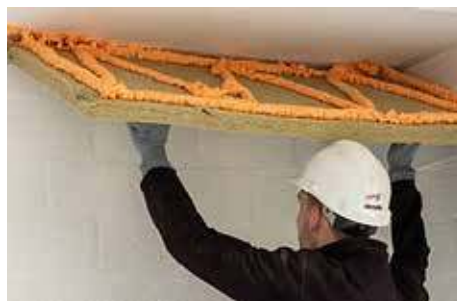
2. Positionner le panneau dans un laps de temps de 2 min.
