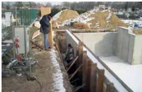
3. Positionner les panneaux.
