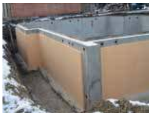
Isolation de cave/par l'extérieur
