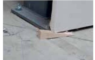
9. Soutenir le panneau de finition d'extrémité
