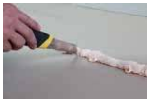
6. La colle peut être coupée. • Easy Fix : après 25 min • Easy Fix Turbo : après 15 min
