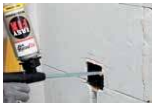
5. Garnir à nouveau le trou de mousse adhésive, si nécessaire
