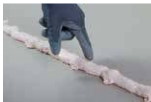
7. La colle a durci. • Easy Fix : après 60 min • Easy Fix Turbo : après 15 min
