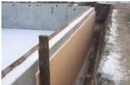
4. Maintenir appuyé pendant quelques minutes.
