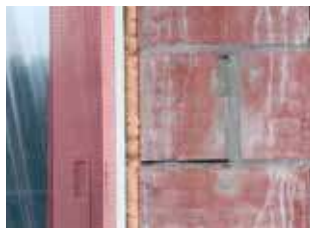
1. Les profilés et raccords doivent être déjà en place.
