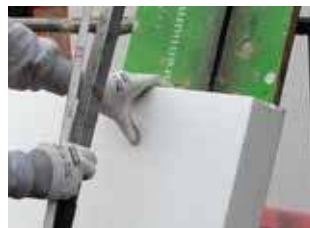
3. Découper le panneau à la mesure exacte.
