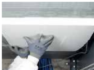
Isolation de plafond
