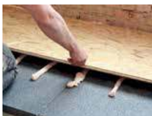
5. Placer le sous-plancher perpendiculairement aux panneaux d'isolation.
