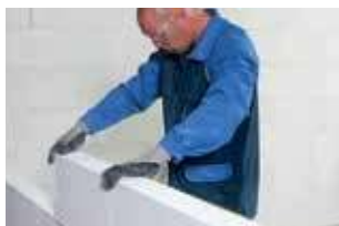
11. Placer la brique suivante contre la brique venant d'être posée
