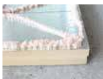
Collage de panneaux d'isolation
