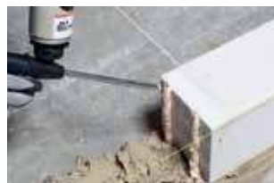
6. Les blocs d'assise peuvent être jointoyés verticalement
