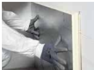
Isolation de murs intérieurs
