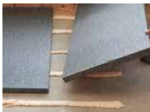
2. Placer l'isolation perpendiculairement aux cordons de colle. Appuyer fortement.
