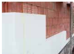
9. Durcissement en 1 heure environ. La finition peut ensuite être poursuivie.
