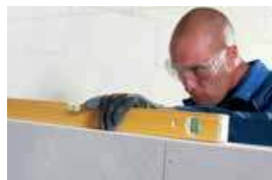
12. Vérifier l'aplomb après chaque couche
