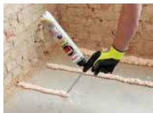
1. Appliquer les cordons de colle sur le support.
