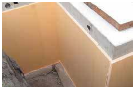
5. Effectuer la finition des angles de raccordement.
