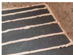
4. Encoller les panneaux d'isolation.
