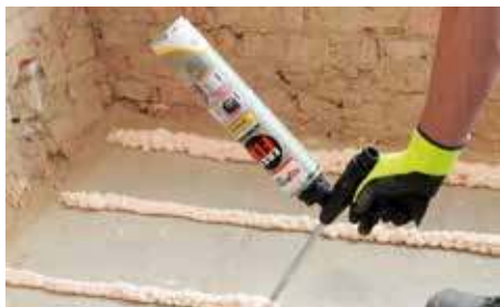
1. Appliquer Easy Fix sur le support.
