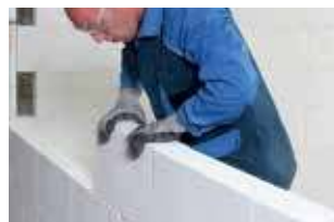
9. Placer la brique dans la couche de colle
