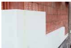
Isolation de façades extérieures avec enduit de finition
