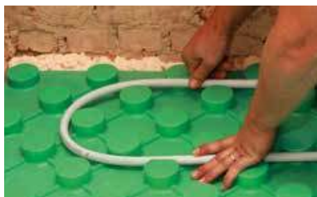
6. Les canalisations peuvent être posées après 1 heure.
