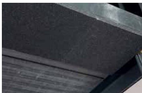
5. ...et la fixation est terminée.
