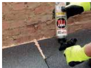
3. Comblers les joints et les interstices.
