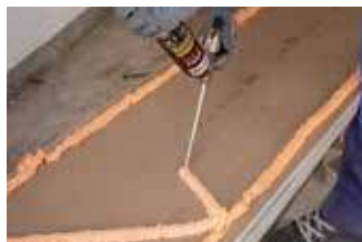
Encollez les plaques de plâtre avec de l'Easy Fix
