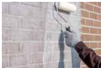
Travaillez selon un schéma en damier (case max. 1 m 2 )
