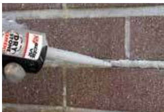
Appliquez le dans le joint bien profondément avec un pistolet à mastics
