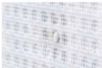
Toujours tendre la membrane entre 2 chevilles
