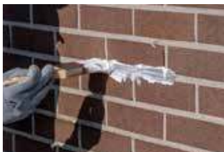
Appliquez une couche supplémentaire sur les irrégularités plus profondes à l'aide d'une brosse
