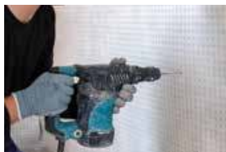
Forer un trou tous les 25 cm au milieu d'une excroissance
