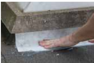
Poussez le DryStone Textile dans une couche humide
