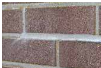
Lisser avec un fer à joint (humide)
