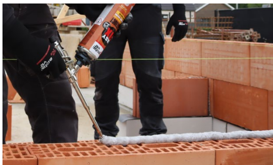
Figuur 1: aanbrengen van de lijm
